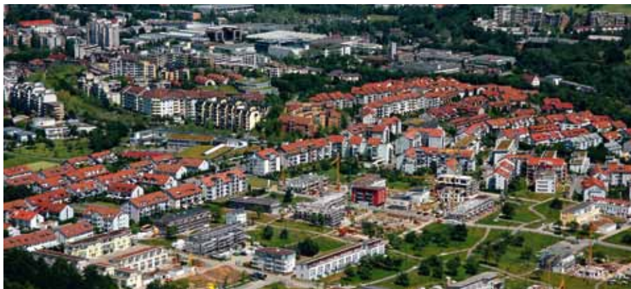
Baugebiet Diezenhalde 4.2 im Bau
